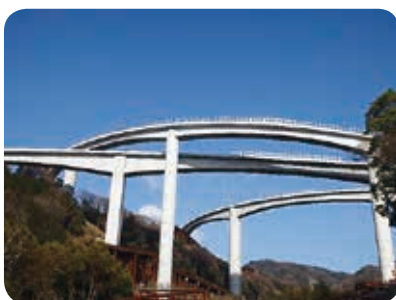
京奈和自動車道紀北西道路 平成29年3月開通 総事業費：約1,160億円
