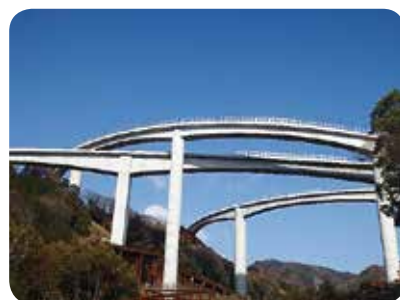
京奈和自動車道紀北西道路 平成29年3月開通 総工費：約1,160億円
