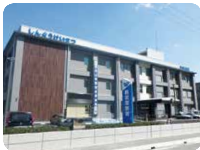
新宮警察署（新宮市） 平成29年3月完成 総工費：約19億円
